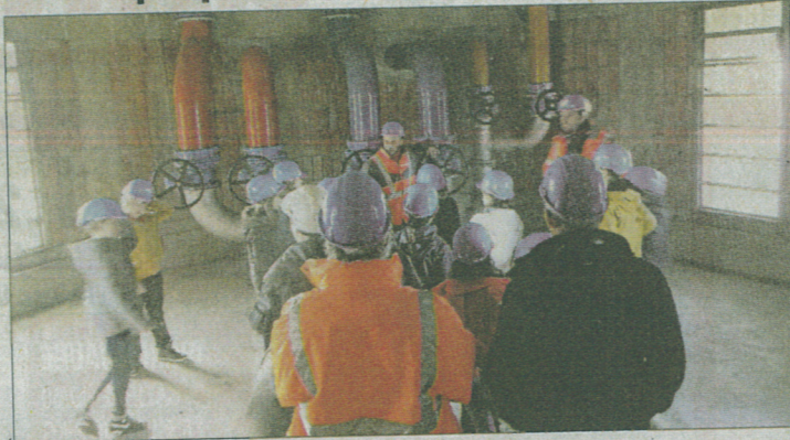
■ Dans la salle des vannes... comme en classe !
